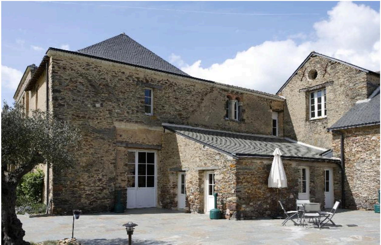
Bâtiment est, façade sud.
