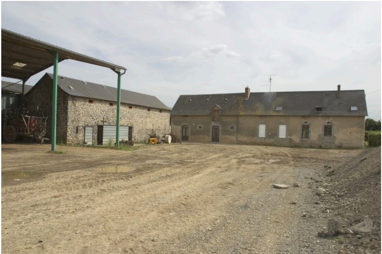
L'étable et le logis vus depuis le nord.
