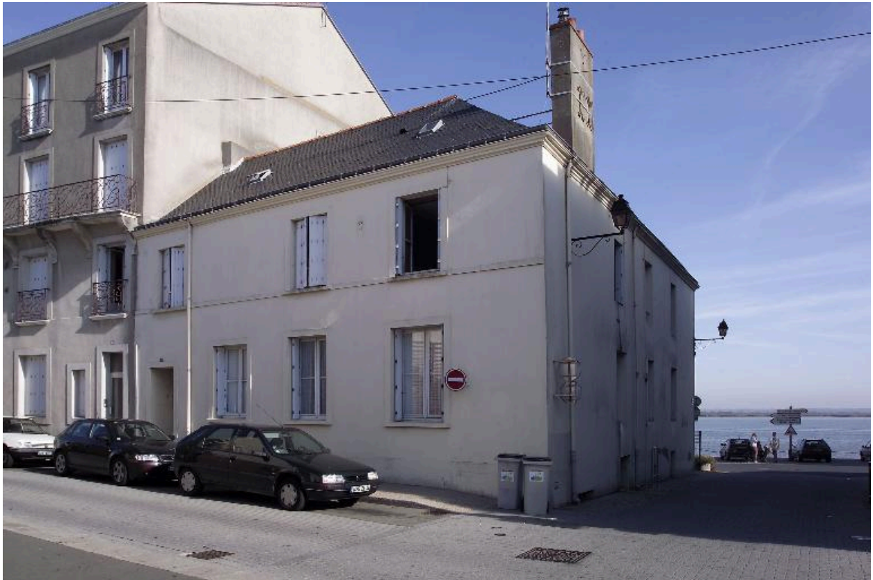
Vue des façades sur la rue du Général-De-Gaulle et sur la rue Pasteur.
