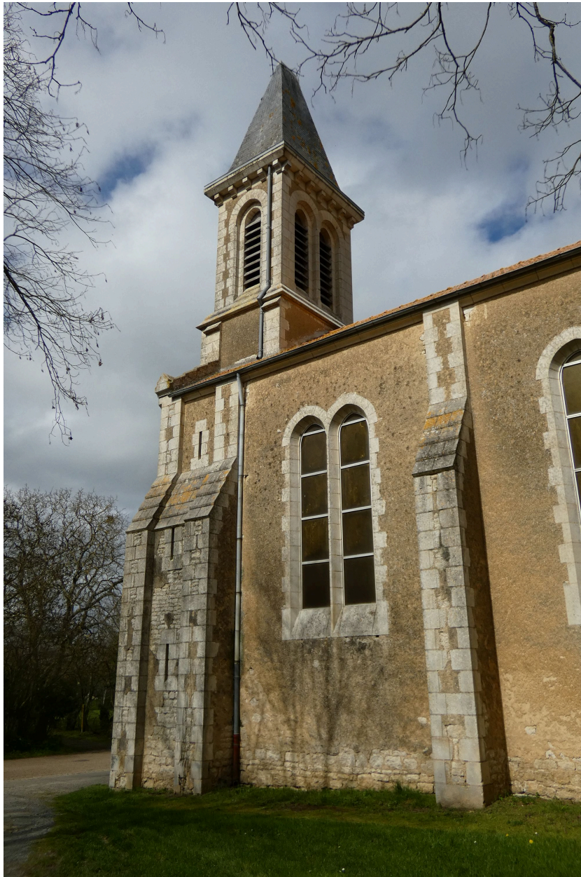
La première travée de la nef et le clocher vus depuis le sud-est.
