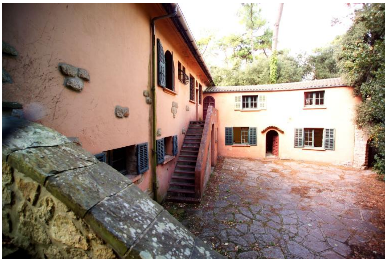
Vue de la façade nord et de l'aile ouest de la villa Maritaye.
