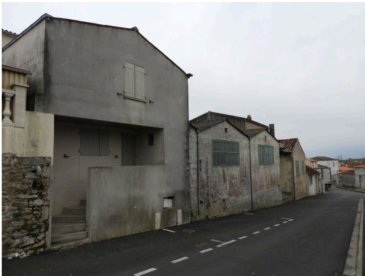
L'ancienne usine vue depuis le nord-est.
