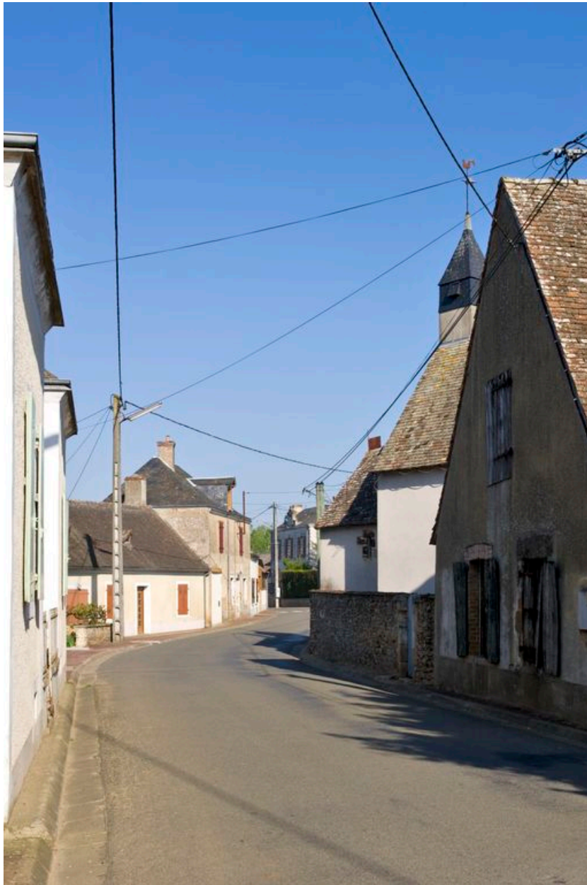
La rue du Centre-Bourg, vue depuis l'est.
