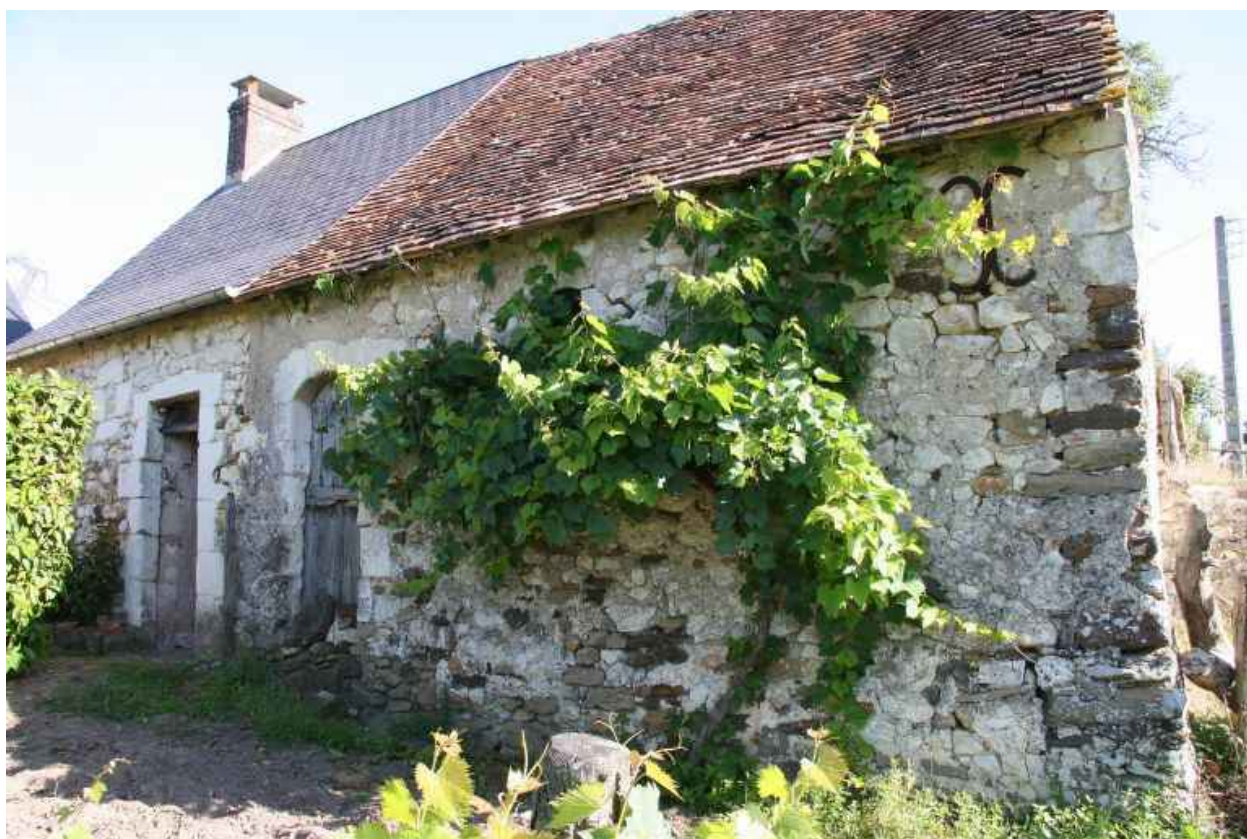
Maison 2 : façade antérieure.
