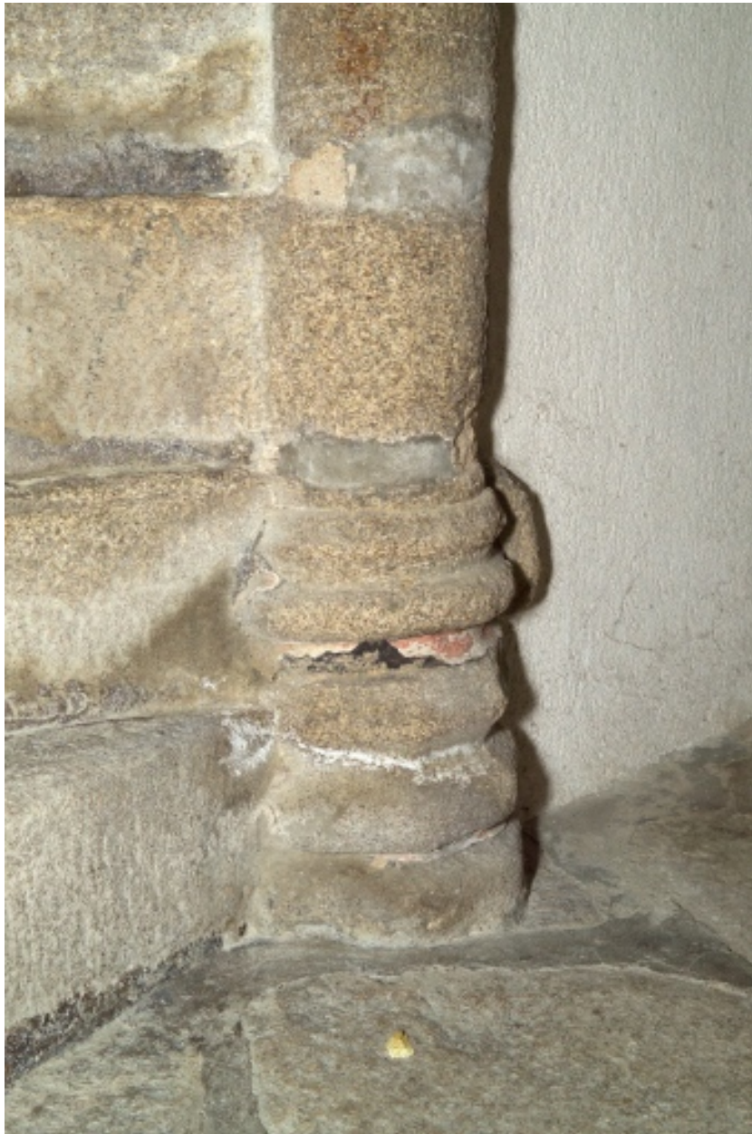
Détail du noyau de l'escalier en vis.
