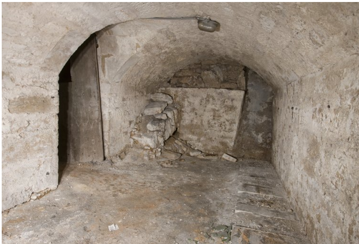
Sous-sol du n° 6 : salle ouest.
