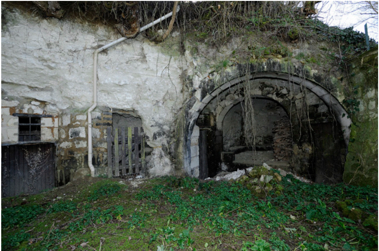
Cavités ouest de l'ensemble
