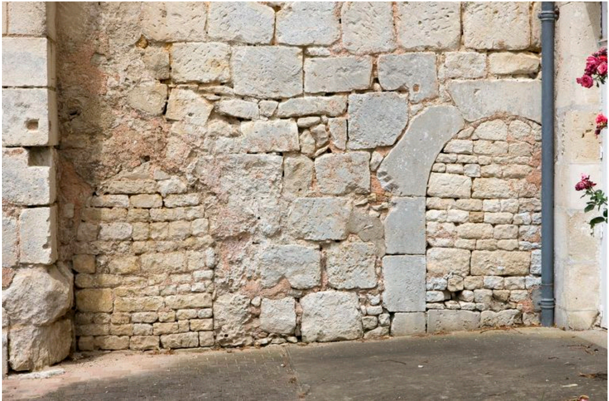
Ouvertures bouchées de la façade sur cour de la chapelle, à l'angle du pavillon Saint-Côme.
