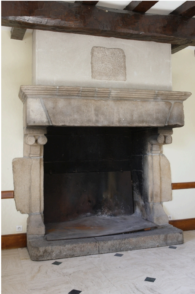
Vue de la cheminée du pignon ouest.
