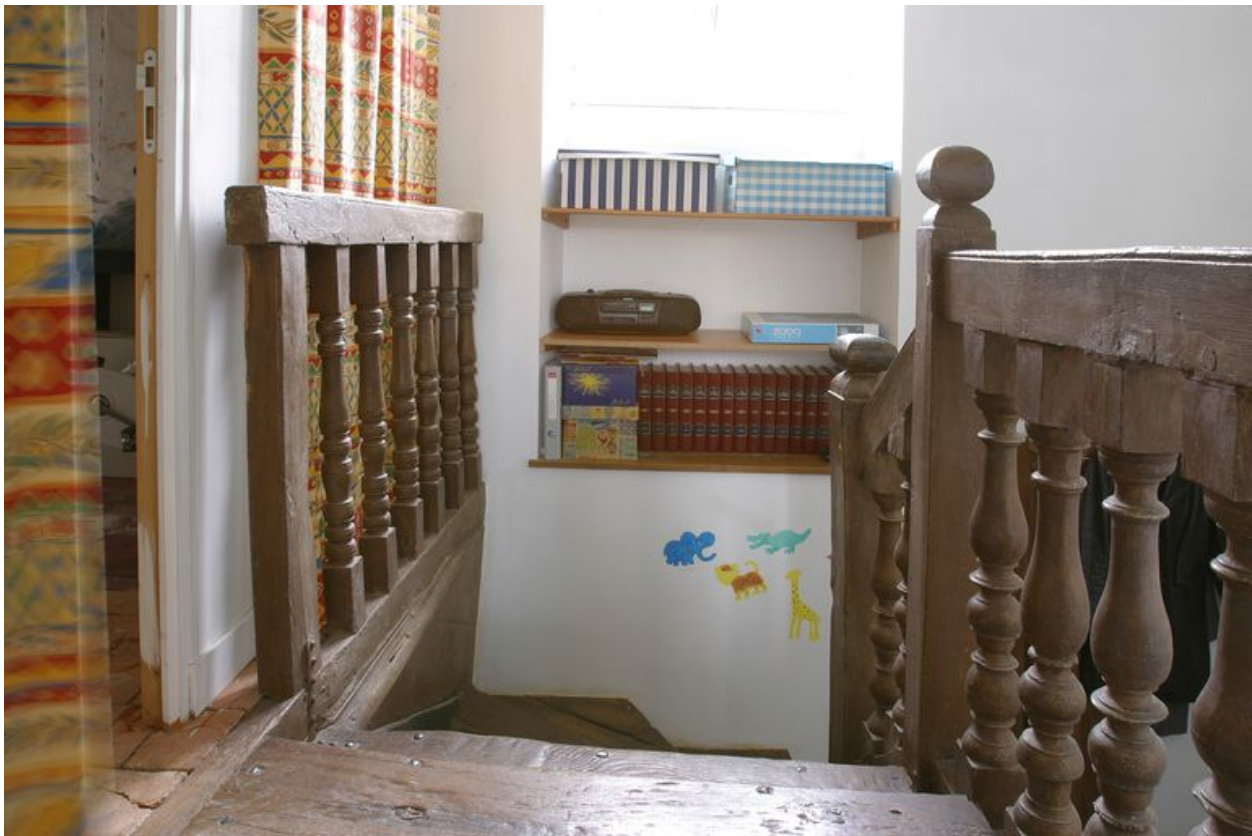
L'escalier vu depuis le palier de l'étage de comble.
