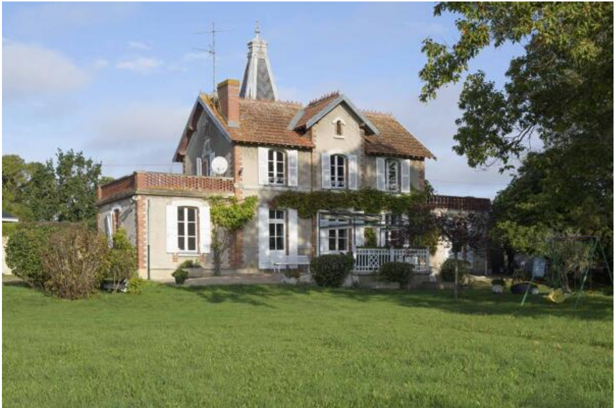
Vue d'ensemble depuis le jardin.
