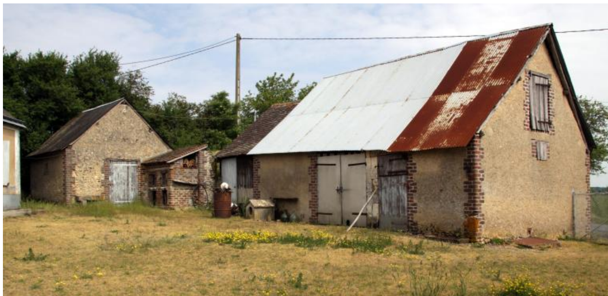
Grange et écuries, façades sur cour.
