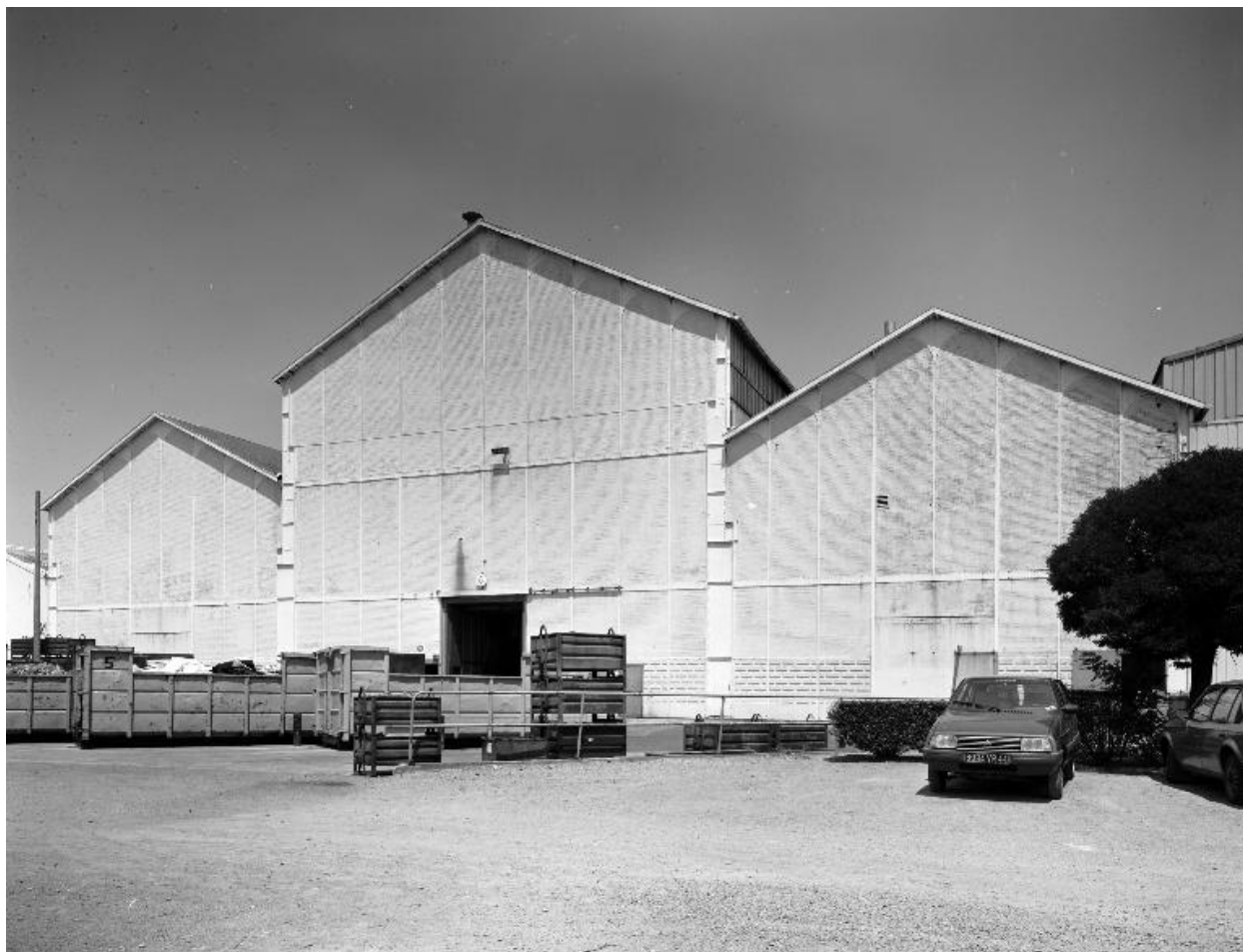
Pignons sud des nefs.
