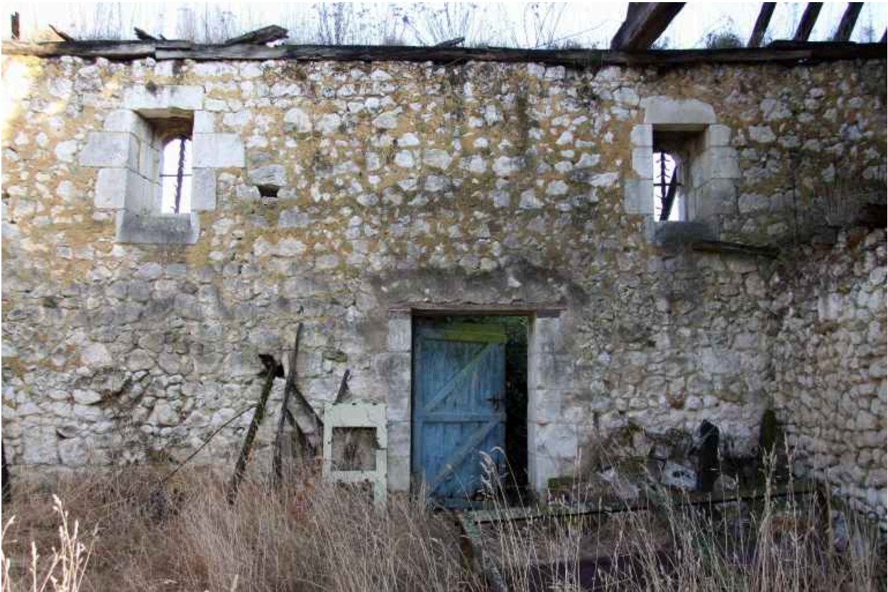
La grange, détail : porte arrière récente ?
