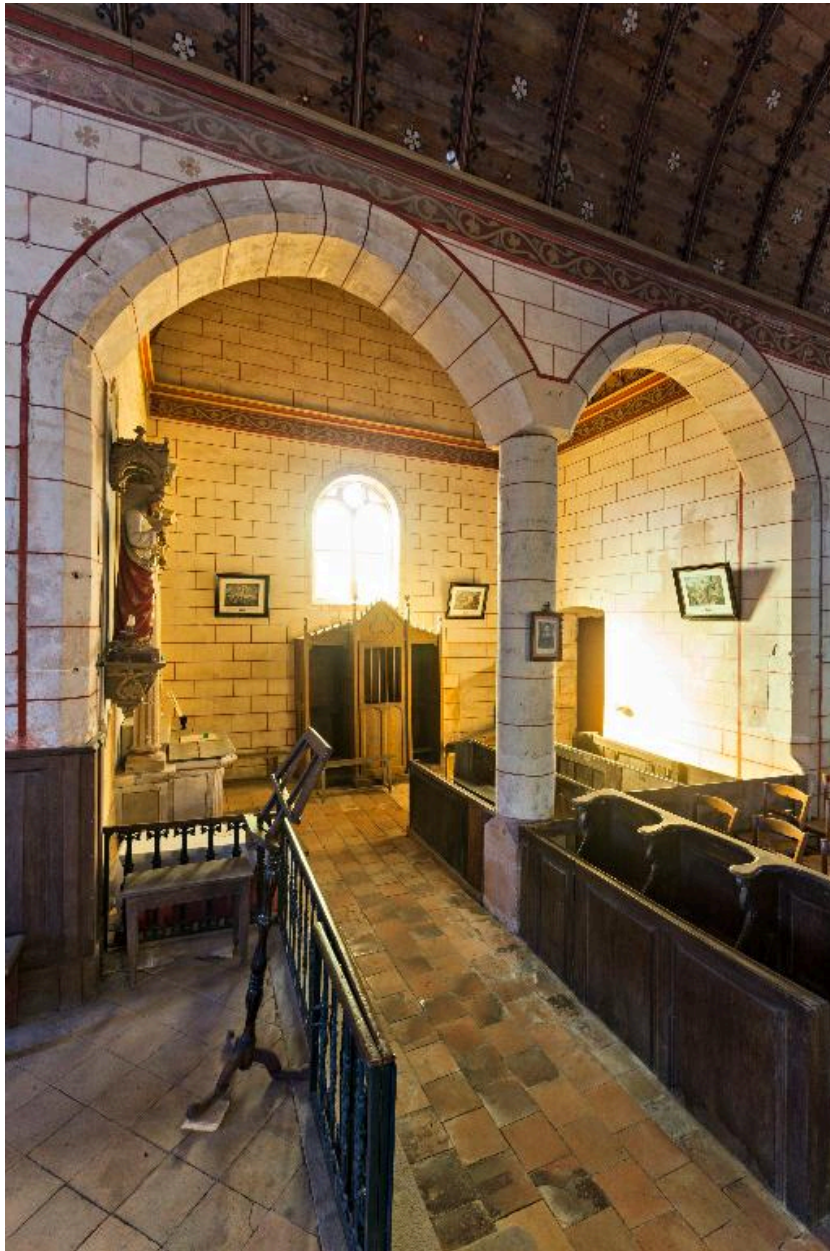
Vue intérieure de la chapelle du bras sud depuis la nef.
