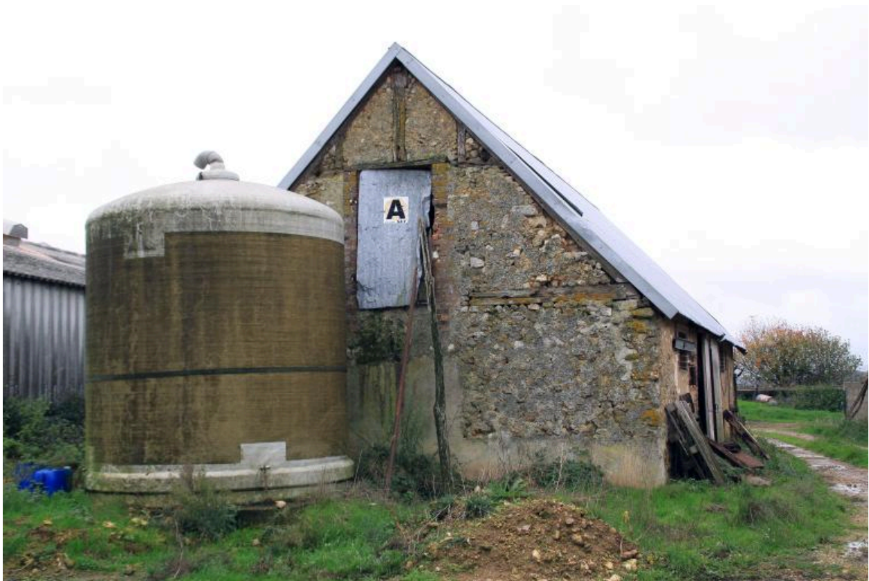
Etable 2 : vestige d'un pignon en pan de bois.
