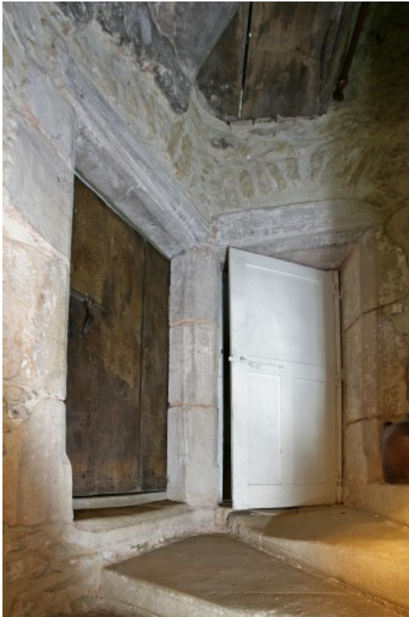
Logis, intérieur : portes d'accès aux chambres hautes de l'aile en retour.
