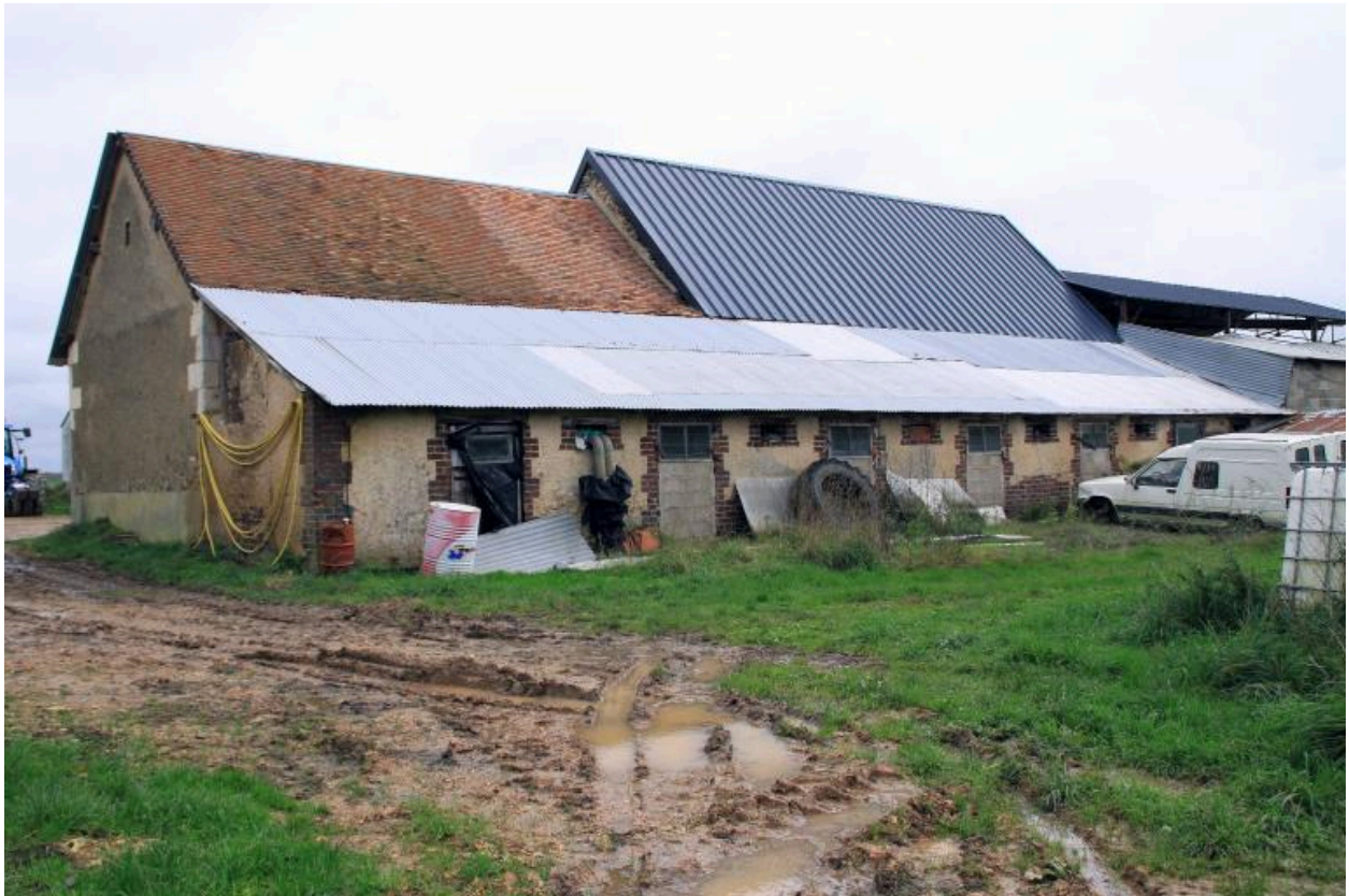
Toits à porcs adossés à la grange et à l'étable.
