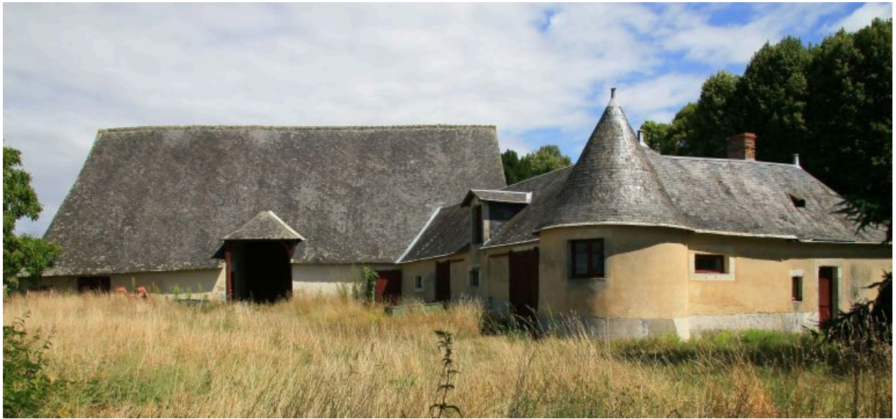
La basse-cour du château : façade postérieure des étables et façade sud de la grange.
