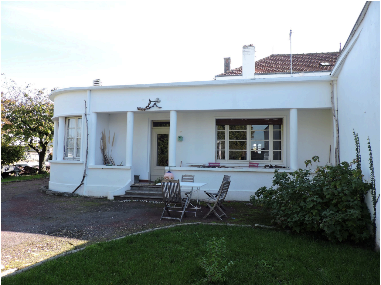
L'aile nord-ouest (milieu du 20e siècle) vue depuis l'ouest.
