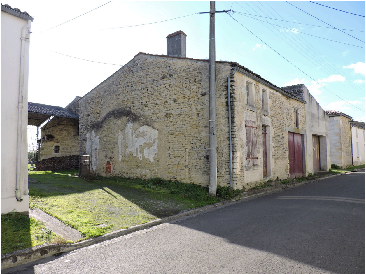
Le logis, au nord-ouest de l'ensemble, vu depuis le nord-est.
