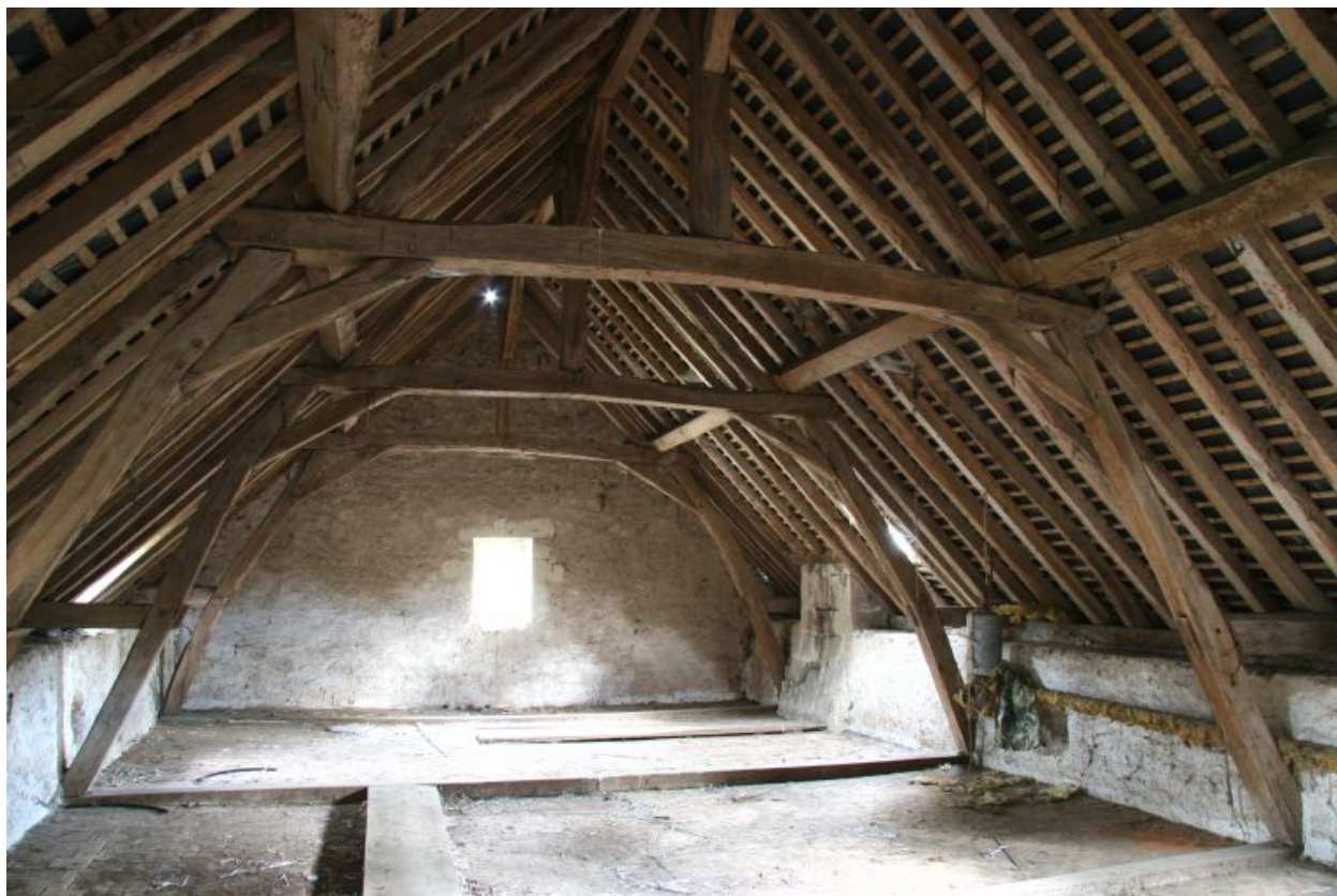
Les communs, logement construit entre 1811 et 1846 : charpente.
