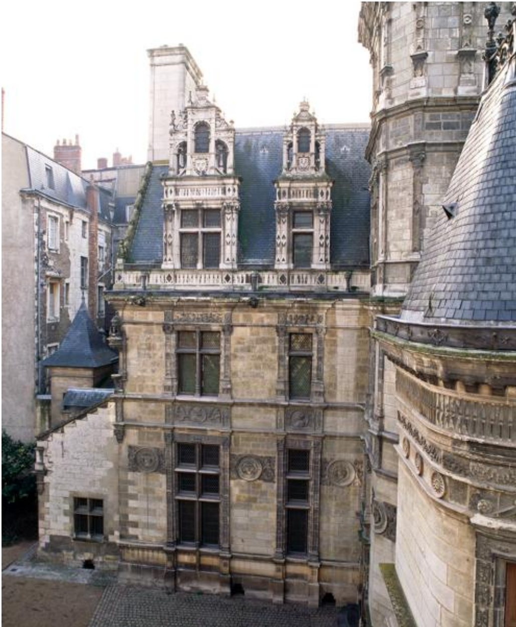
Corps de logis gauche : élévation antérieure.
