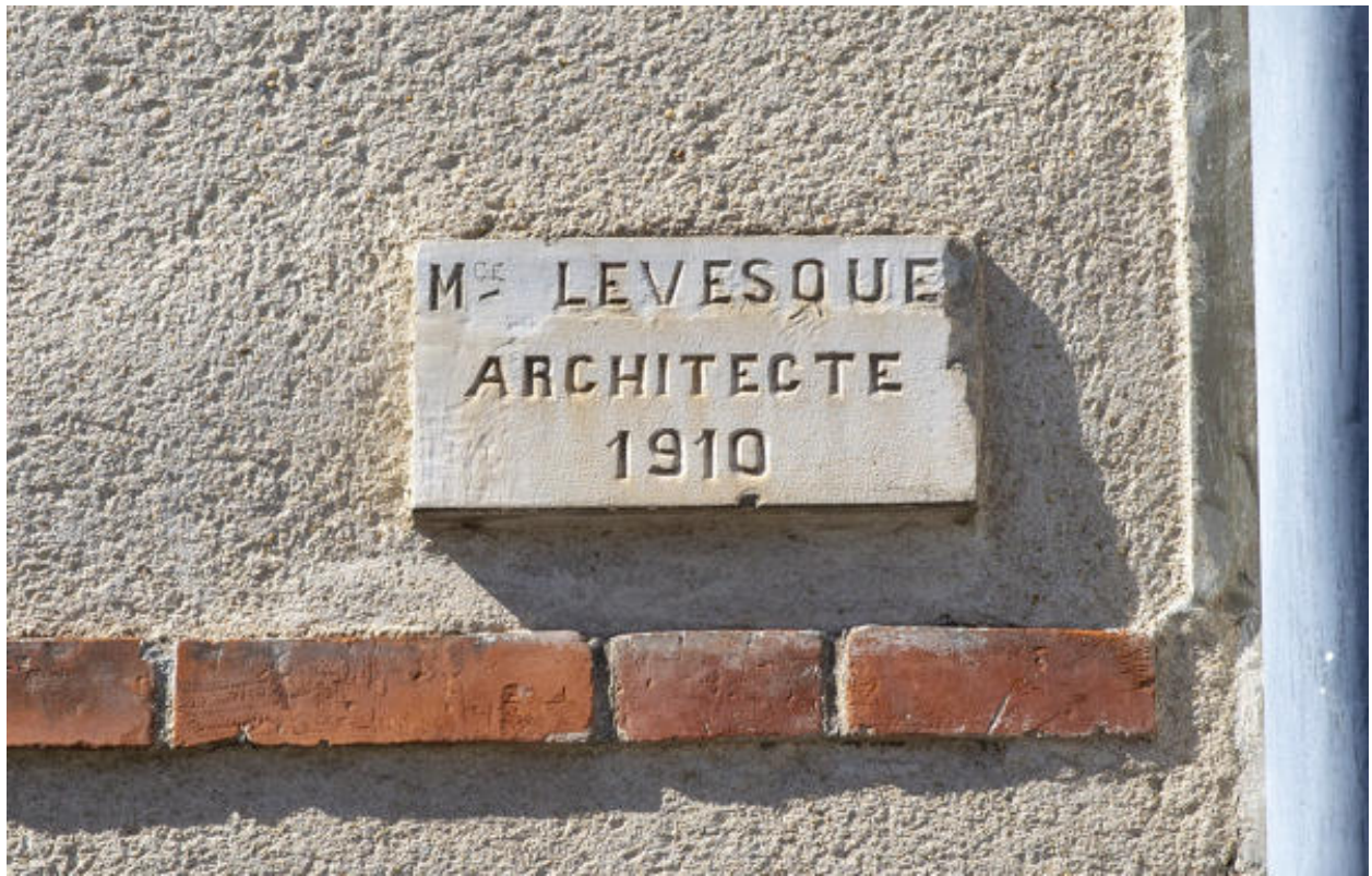
Vue d'une plaque d'architecte Levesque sur une maison rue Hoche.
