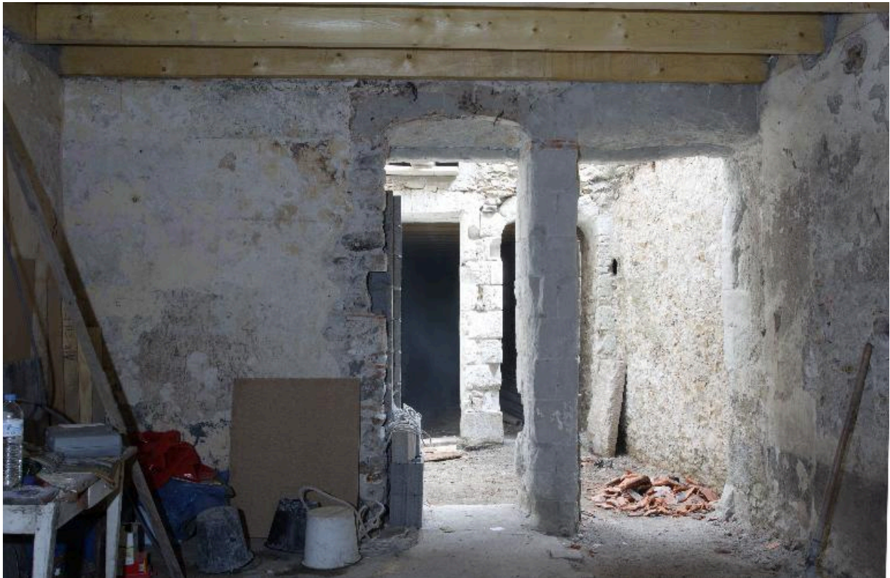
Maison n° 12 : rez-de-chaussée, vue prise vers la cour après la démolition du mur de refend isolant le couloir (à droite) de la pièce.
