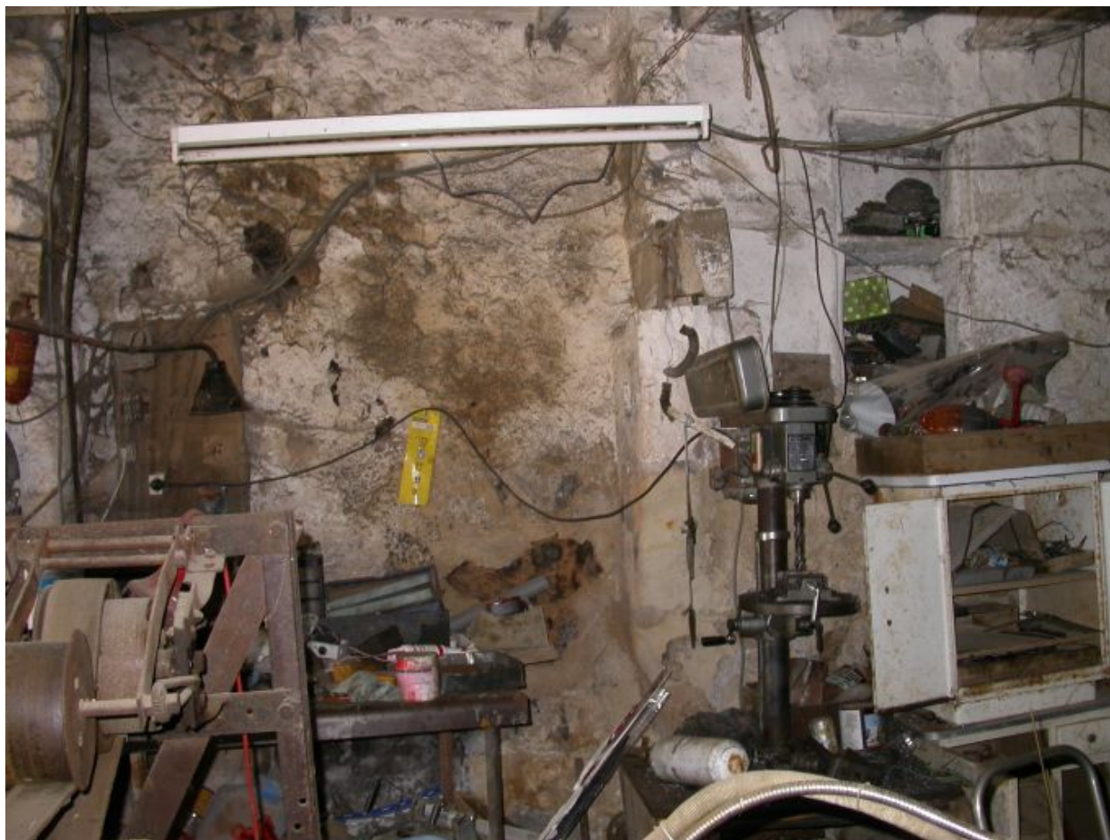
Logements de commis : vestiges d'une cheminée XV-XVIe siècle et son placard dans le mur.
