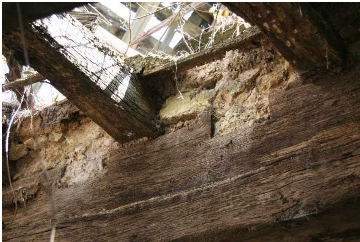
Maison n°2, poutre maîtresse : plafond remanié.
