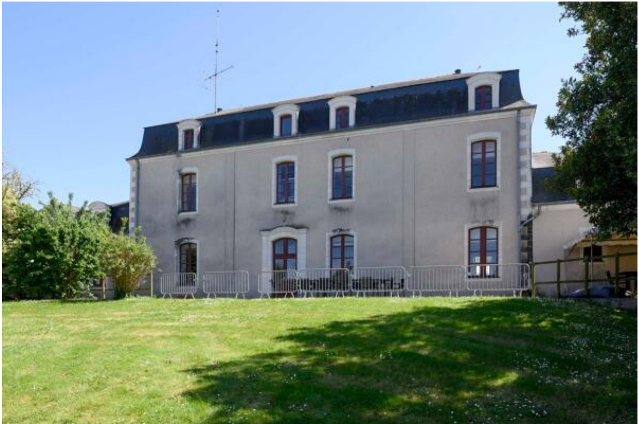
Vue de la façade nord.
