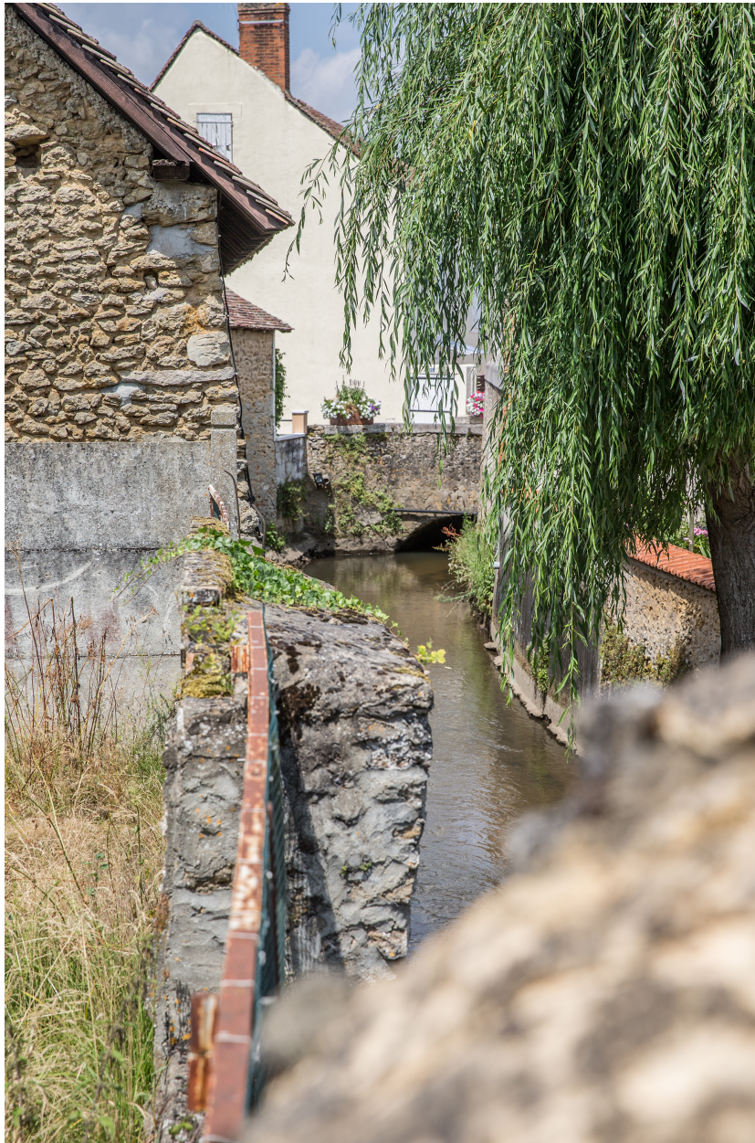
Un pan de rempart le long du Dué, près de la rue des Vieux Ponts.
