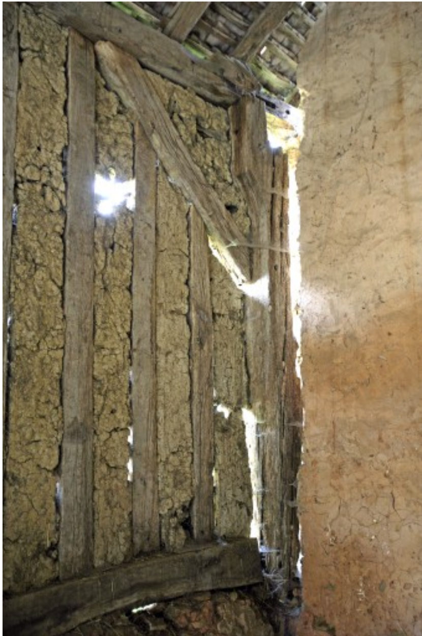
Grange-étables-remise, vue intérieure : angle sud-est.
