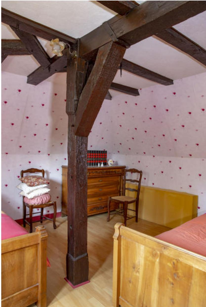
Vue de la partie inférieure du poinçon avec aisselier et de la sous-faitage avec l'enrayure nord à l'arrière.
