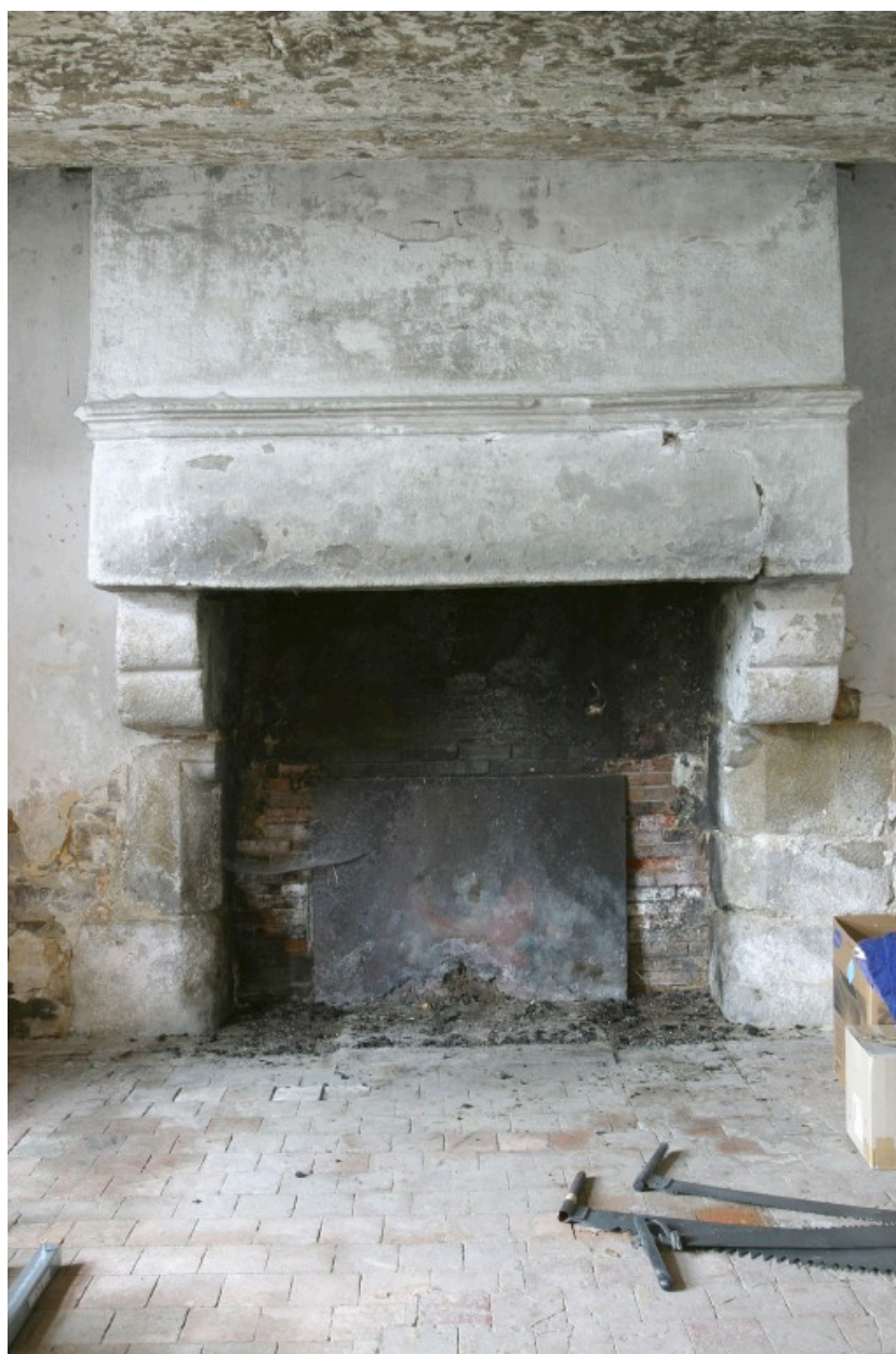
Rez-de-chaussée. Grande pièce : la cheminée.
