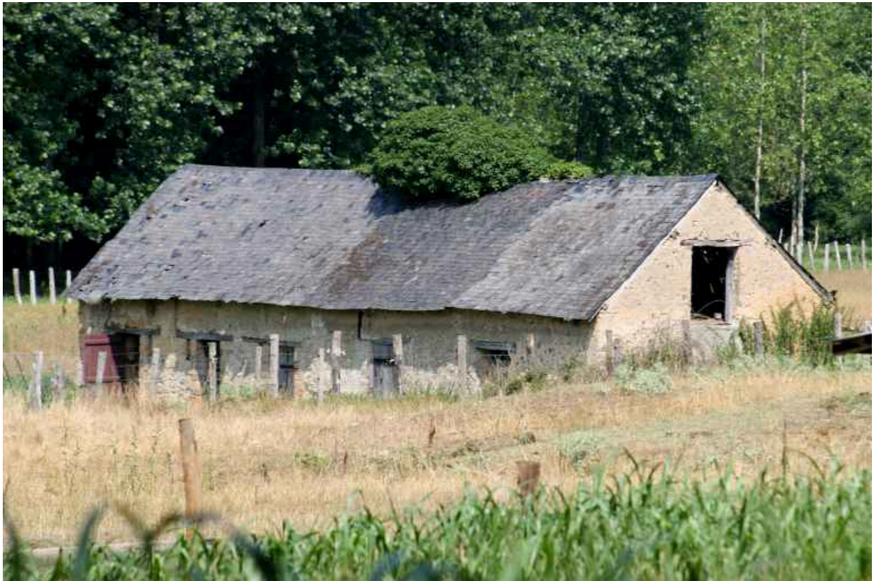
Aignement de toits à porcs sous un même toit.
