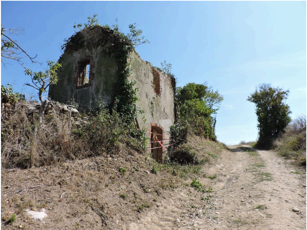
Le belvédère, avant restauration, vu depuis l'ouest.
