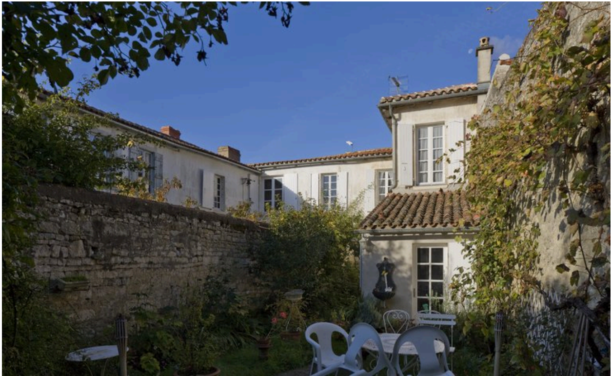
Vue de l'arrière de la maison prise du nord-est, du jardin.
