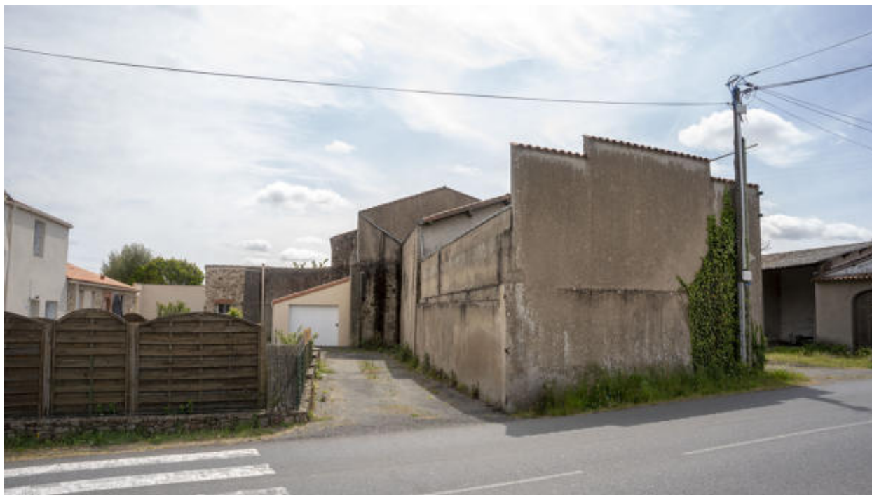
Vue générale de l'aile nord.
