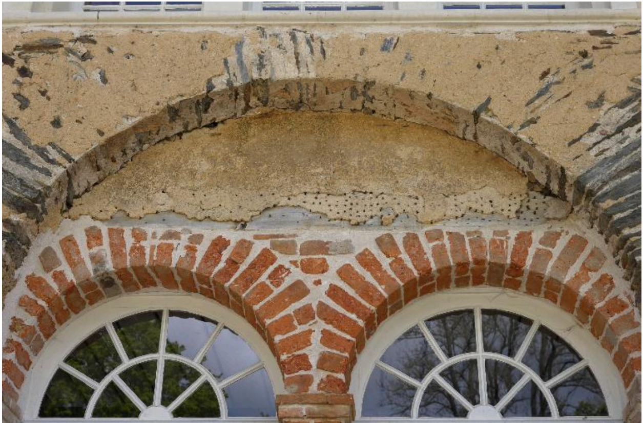
Bâtiment est, détail façade nord.
