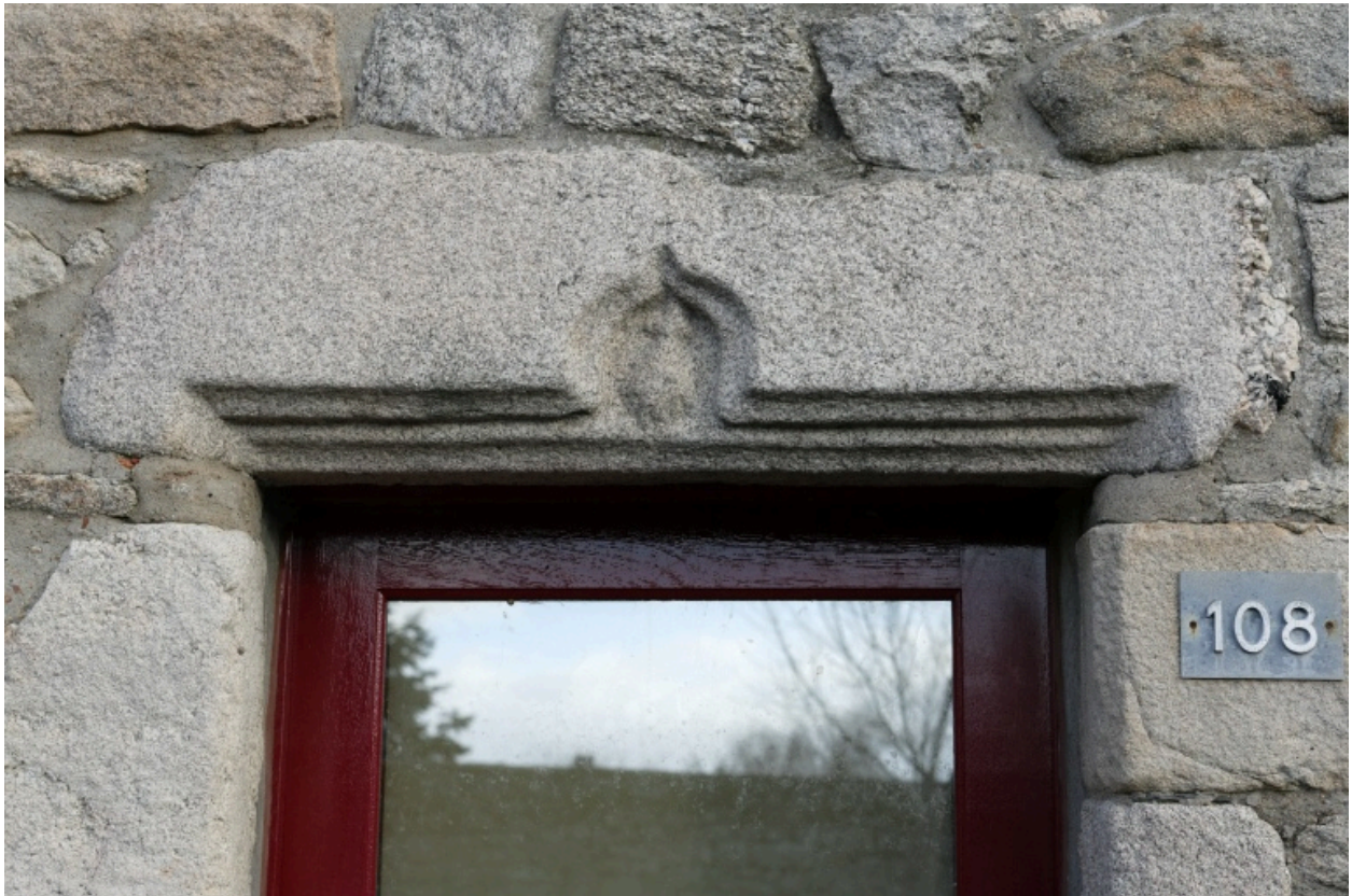
Façade sur rue, détail d'encadrement de porte.
