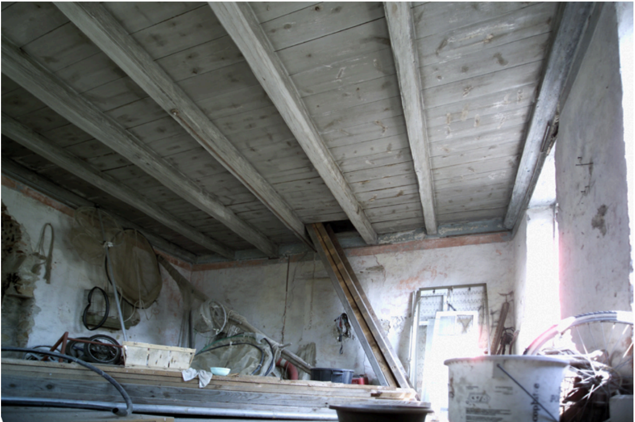
Vue d'ensemble de la pièce au rez-de-chaussée.
