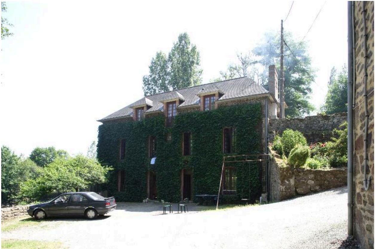
Le moulin vu depuis la cour à l'ouest.
