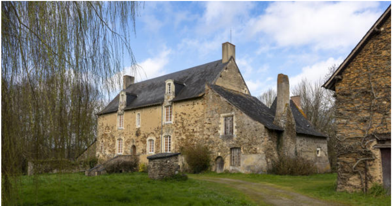
La façade antérieure et l'appentis.
