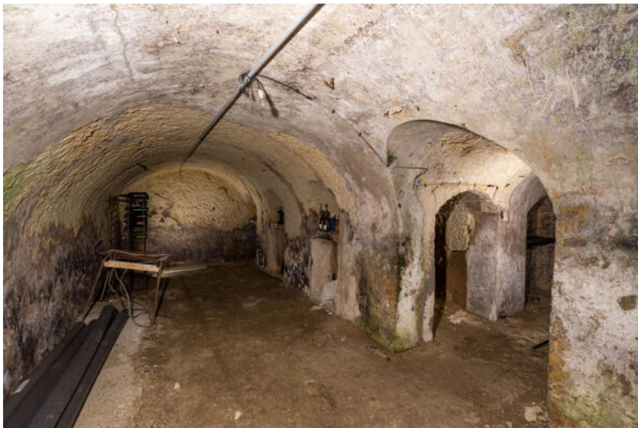
Cellier troglodytique (ouest) : intérieur.
