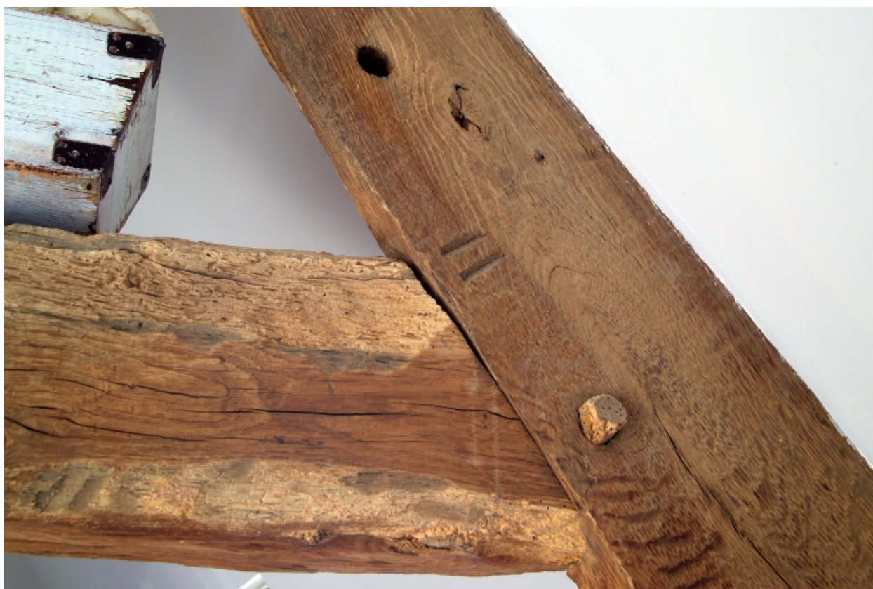
Marque d'assemblage, charpente du corps nord.
