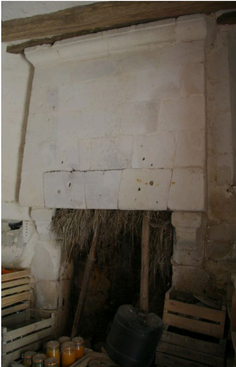
Tourelle, rez-de-chaussée : cheminée.
