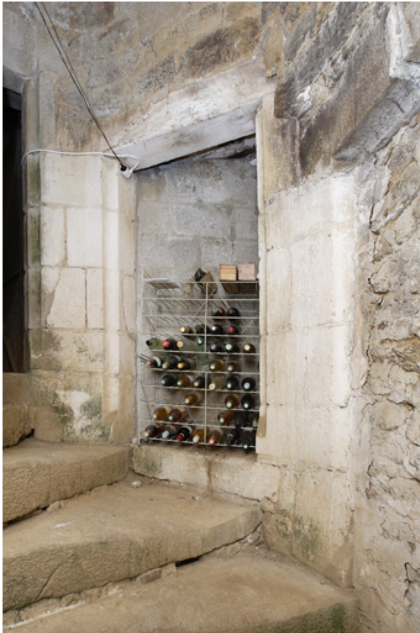
Logis. Tour d'escalier. 2e niveau. Porte d'accès à la salle ouest.
