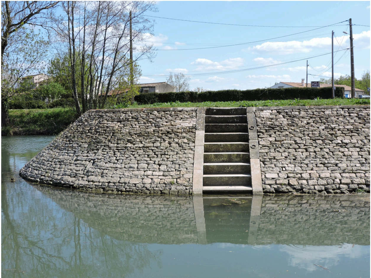
Perré, musoir et escalier à l'extrémité nord de l'îlot central.
